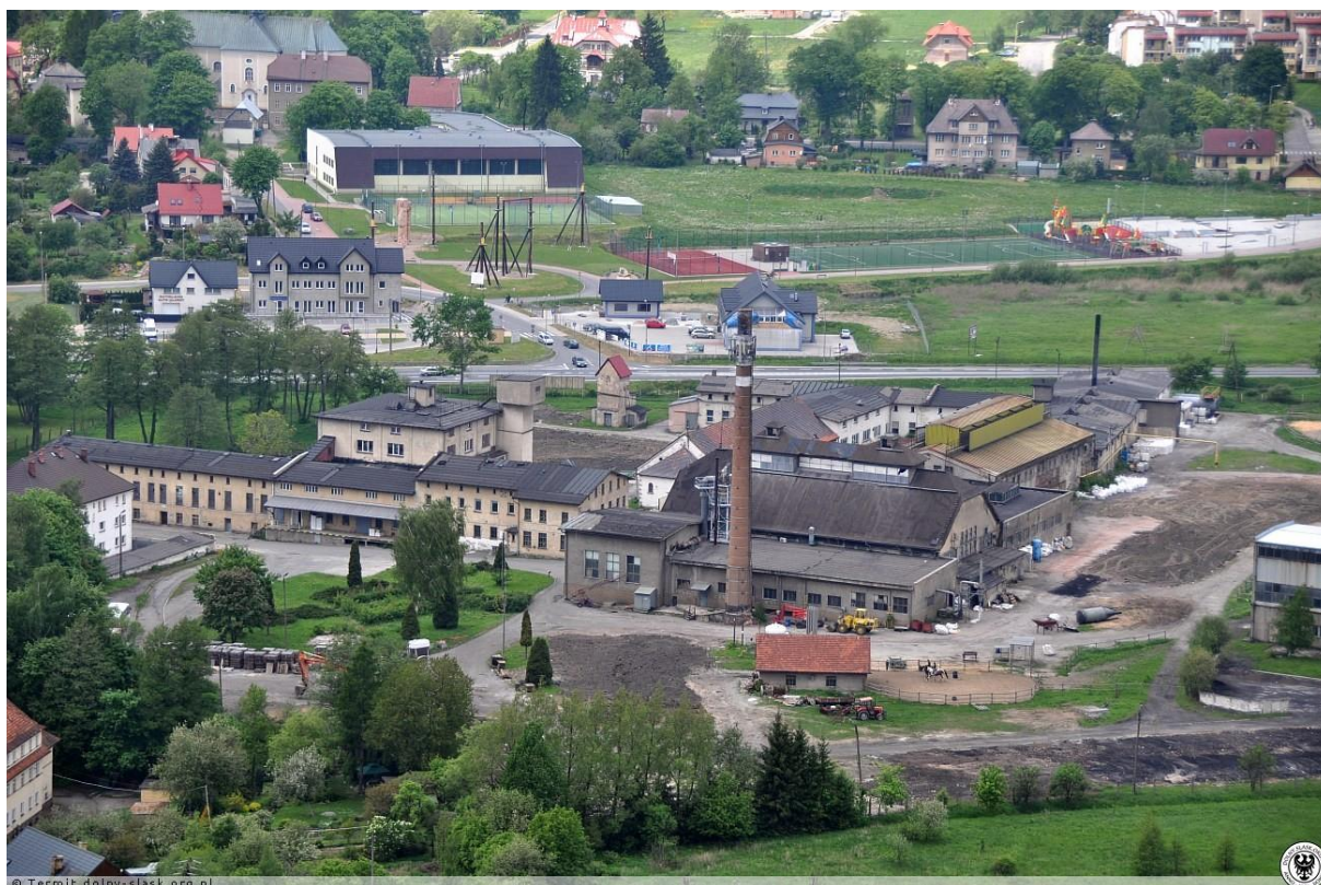
Fot. 4: Zabudowania huty szkła Sudety przed wyburzeniem 19
